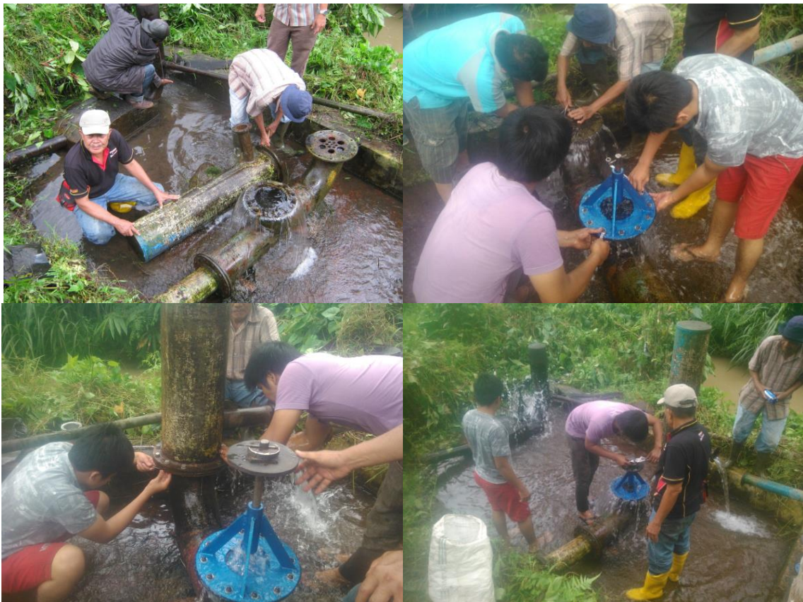
Gambar 8. Proses pemasangan pompa hidram di lokasi PKM
